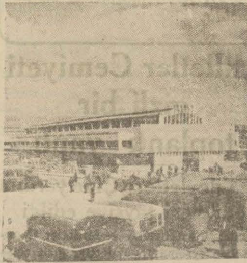
İstanbul Hal binası
